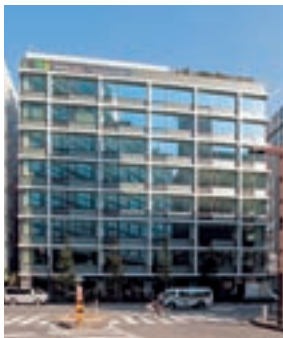
新宿フロントプレイスセンター建物外観
